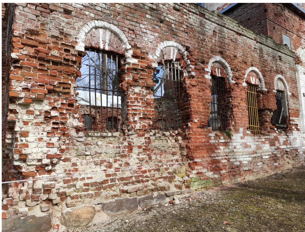
4. Южный фасад трапезной
