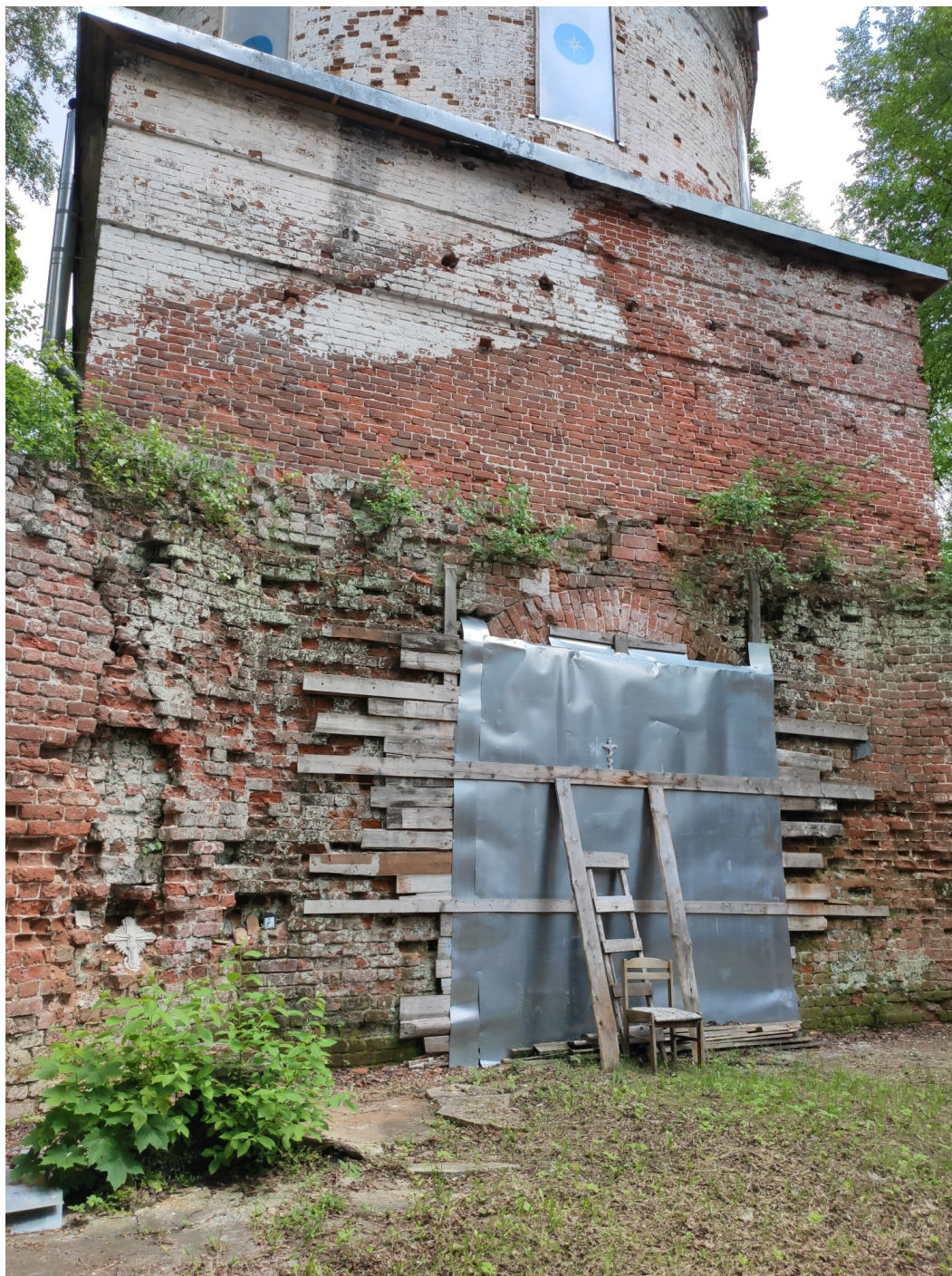
12. Восточная стена трапезной.
